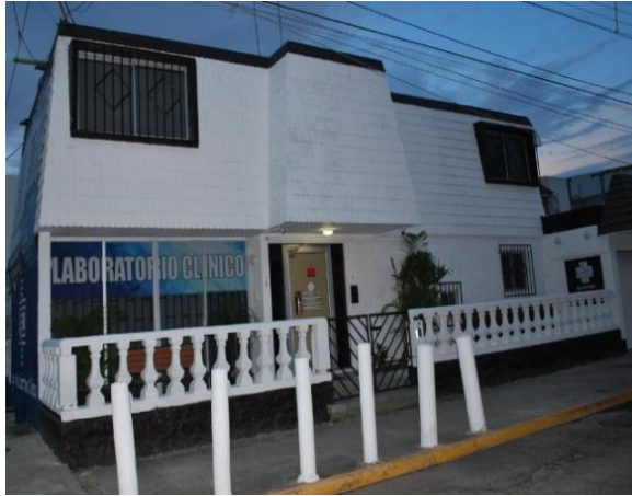
Figura 4.- fachada exterior del laboratorio quantum
