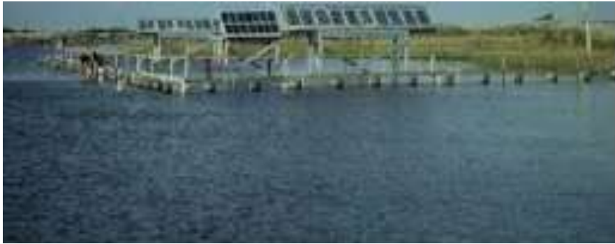
Figura 16. Instalación piloto de arrecifes por electroposición en el caribe con su fuente de energía solar (Tomado de MARENTER).
