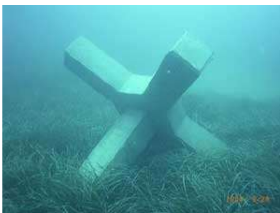
Figura 6. Módulo estructural antiarrastre
