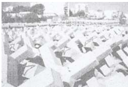
Figura 31- Estructura de Protección
