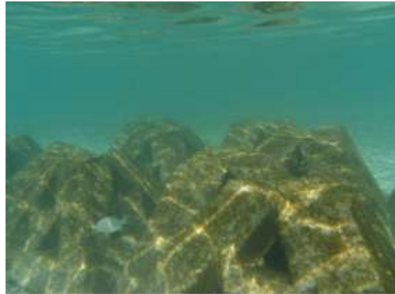
Figura 3. Módulo Pirámide (hormigón armado).
