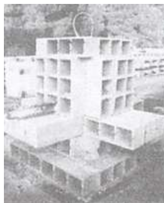
Figura 8. Módulo arrecifal mixto de protección-reproducción (hormigón armado)
