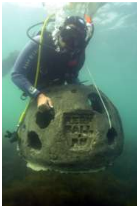
Figura 19. Buzo colocando estructura reef ball
