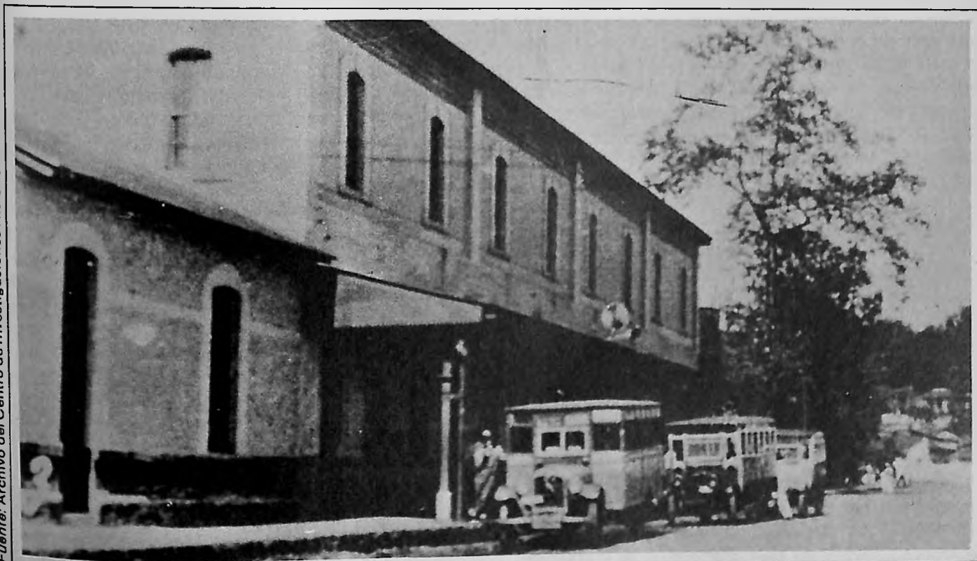
Estación del F. C. I.
