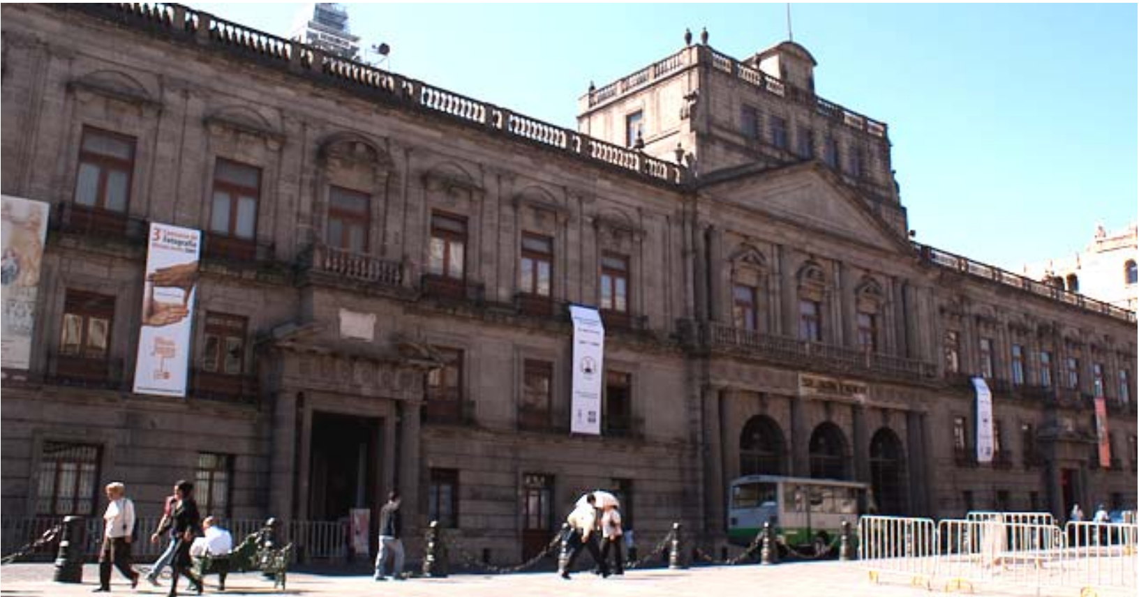
Figura 28. Palacio de Minería. Manuel Tolsá, célebre arquitecto de esa época, presentó el proyecto de este edificio en 1797, comenzando la obra ese mismo año. Imagen de libre circulación en internet.
