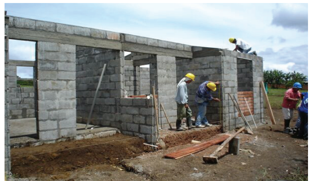
Fig. 5. Construcción de vivienda de Interés Social, 2008. Fuente: Circulación libre de internet
