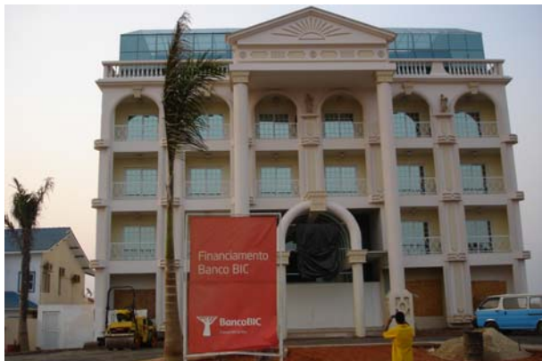
Fig. 6. Edificio de oficinas en construcción, Talatona, noviembre de 2008. Imagen del autor.
