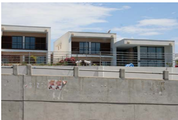
Fig. 8. Muro de cerramiento exterior de una urbanización de viviendas, Talatona, noviembre de 2008. Imagen de Nabil Bonduki
